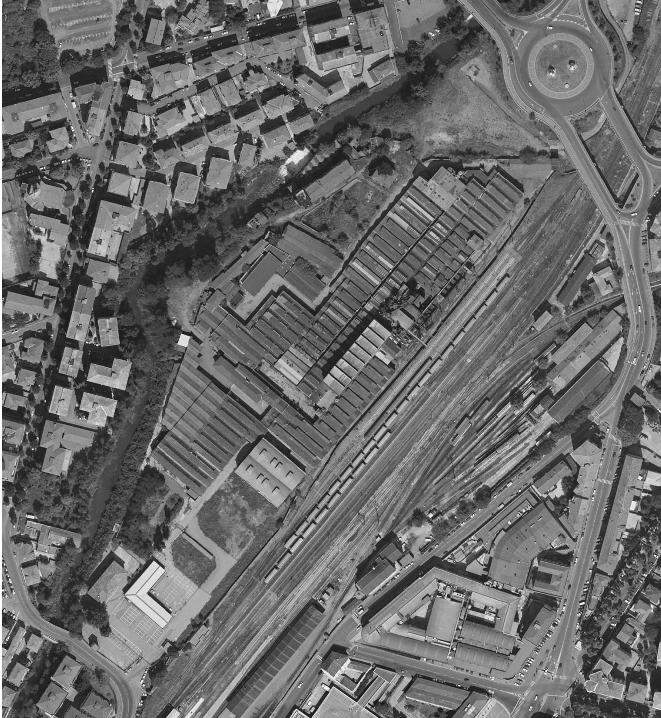
vista aerea dell' Ex Neca prima della demolizione dei fabbricati
