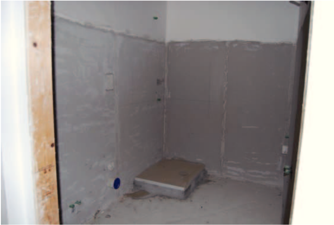
Fotografia C.18 - Condominio Ginestra - Interno appartamenti particolare bagni
