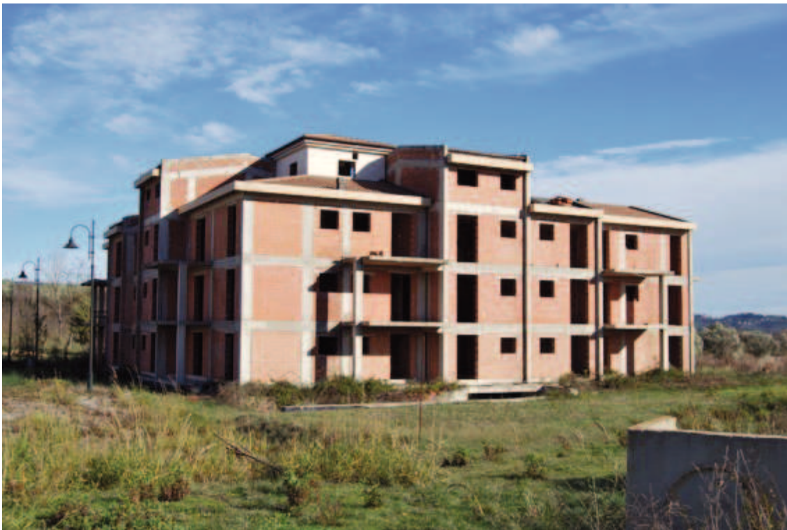
Fotografia C.25 - Condominio Azalea - Lato Ovest
