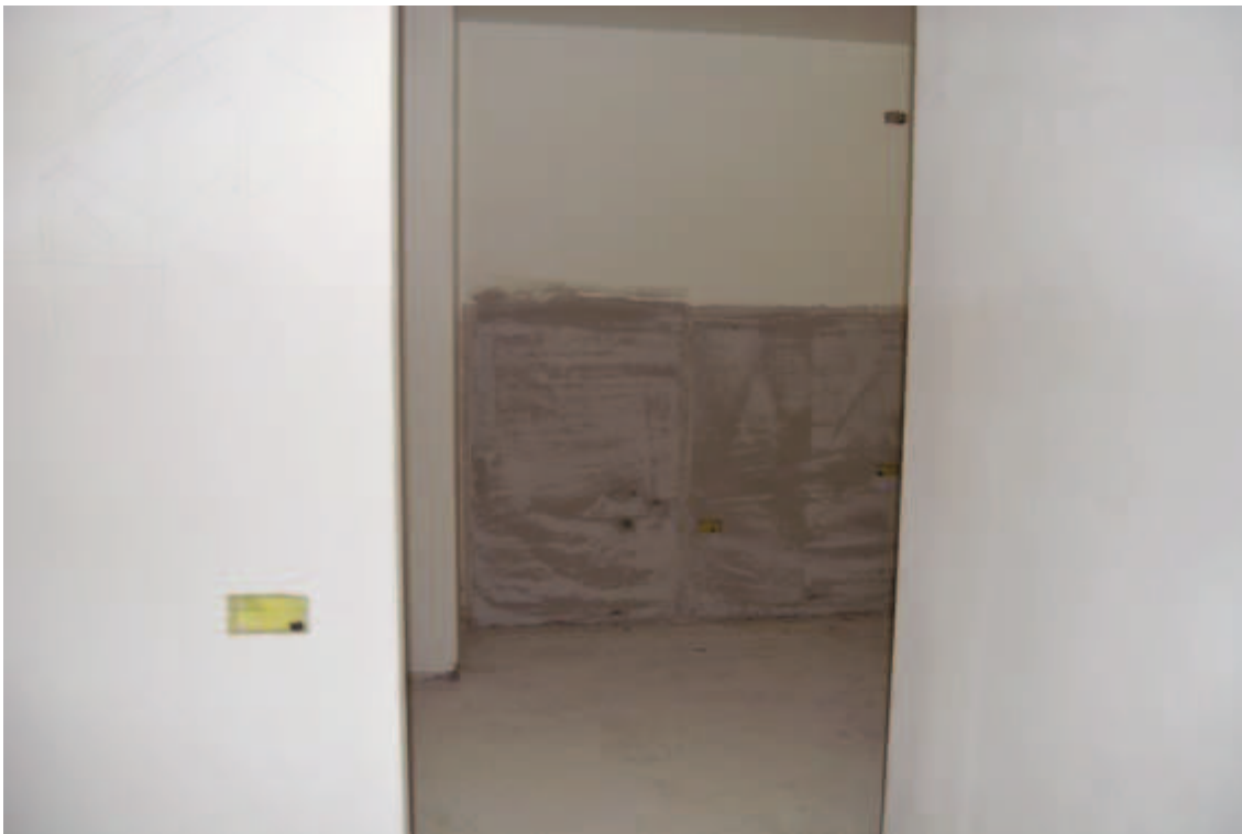
Fotografia C.19 - Condominio Ginestra - Interno appartamenti particolare cucine
