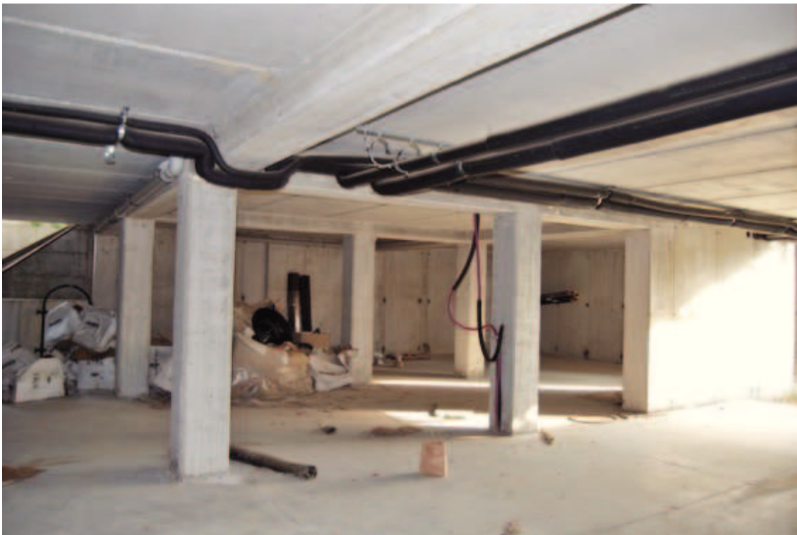
Fotografia C.13 - Condominio Ginestra - Piano Interrato
