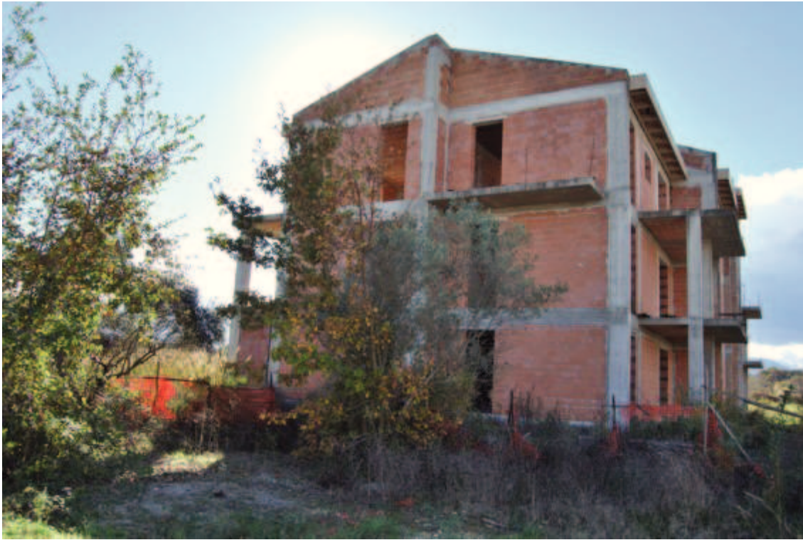
Fotografia C.26 - Condominio Azalea - Lato Est
