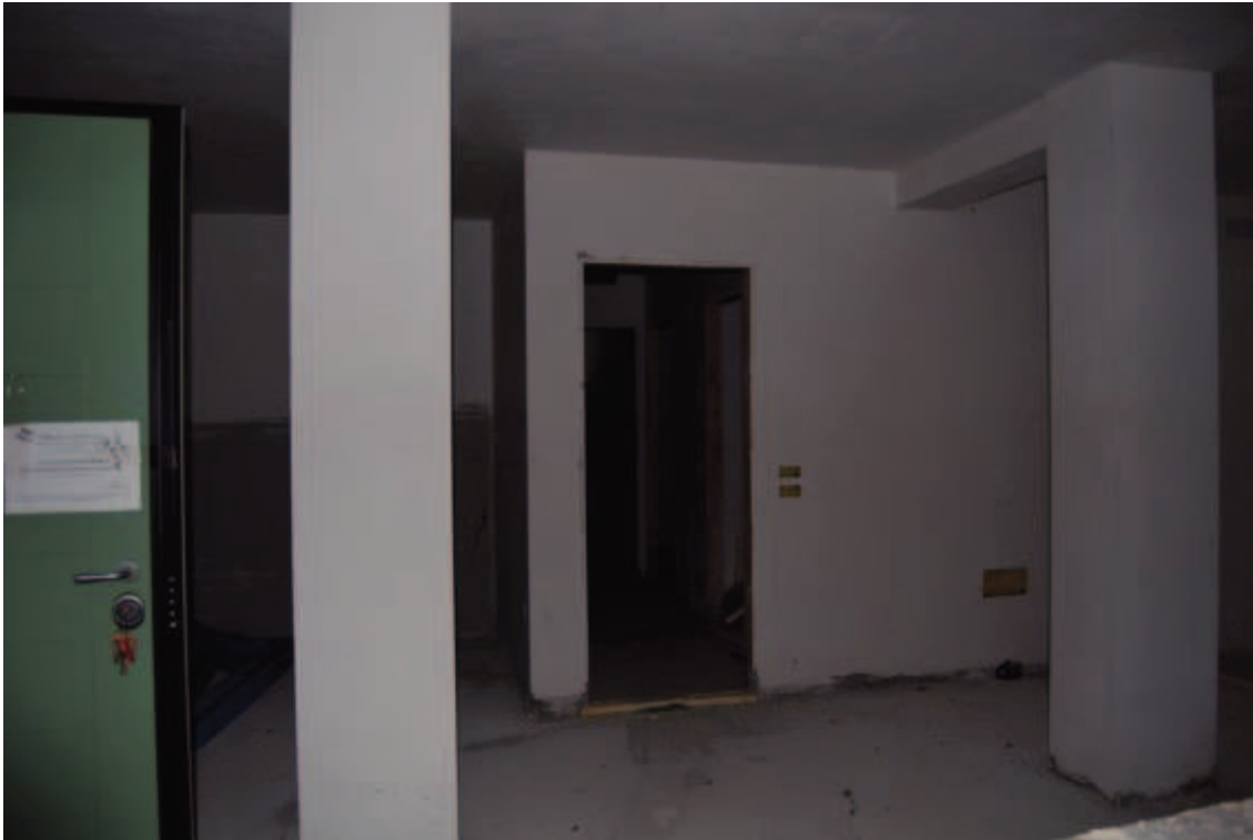
Fotografia C.16 - Condominio Ginestra - Interno appartamenti 1
