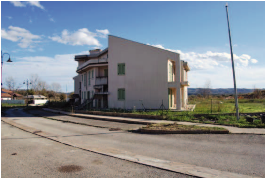
Fotografia C.11 - Condominio Ginestra - Prospetto Nord
