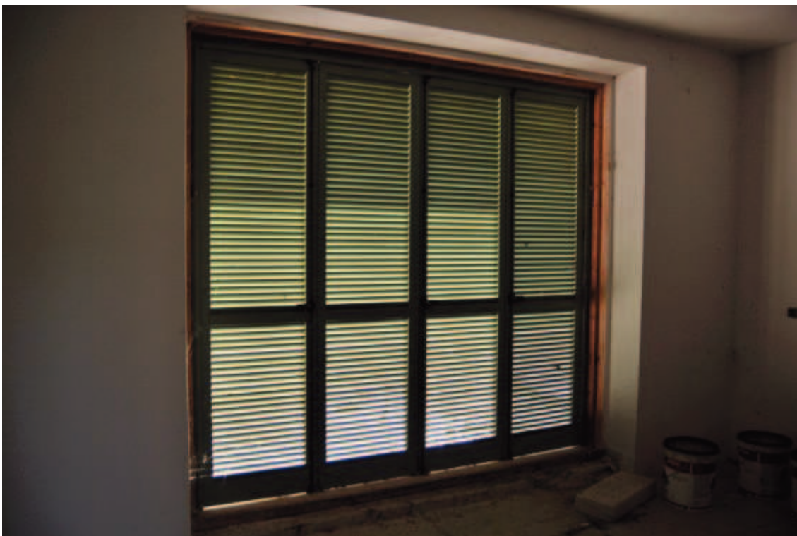
Fotografia C.21 - Condominio Ginestra - Interno appartamenti particolare persiane
