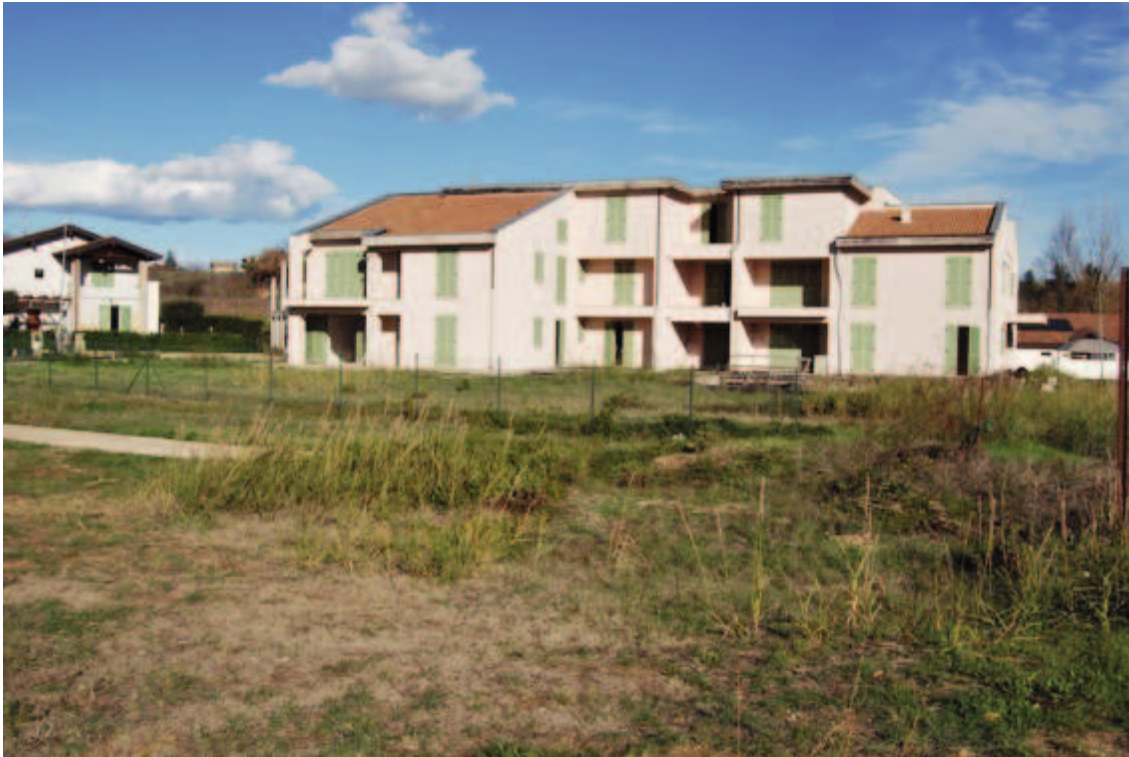
Fotografia C.10 - Condominio Ginestra - Prospetto Lato Sud-Ovest
