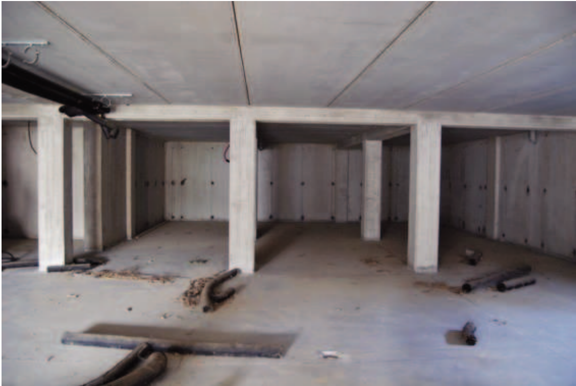
Fotografia C.12 - Condominio Ginestra - Piano interrato
