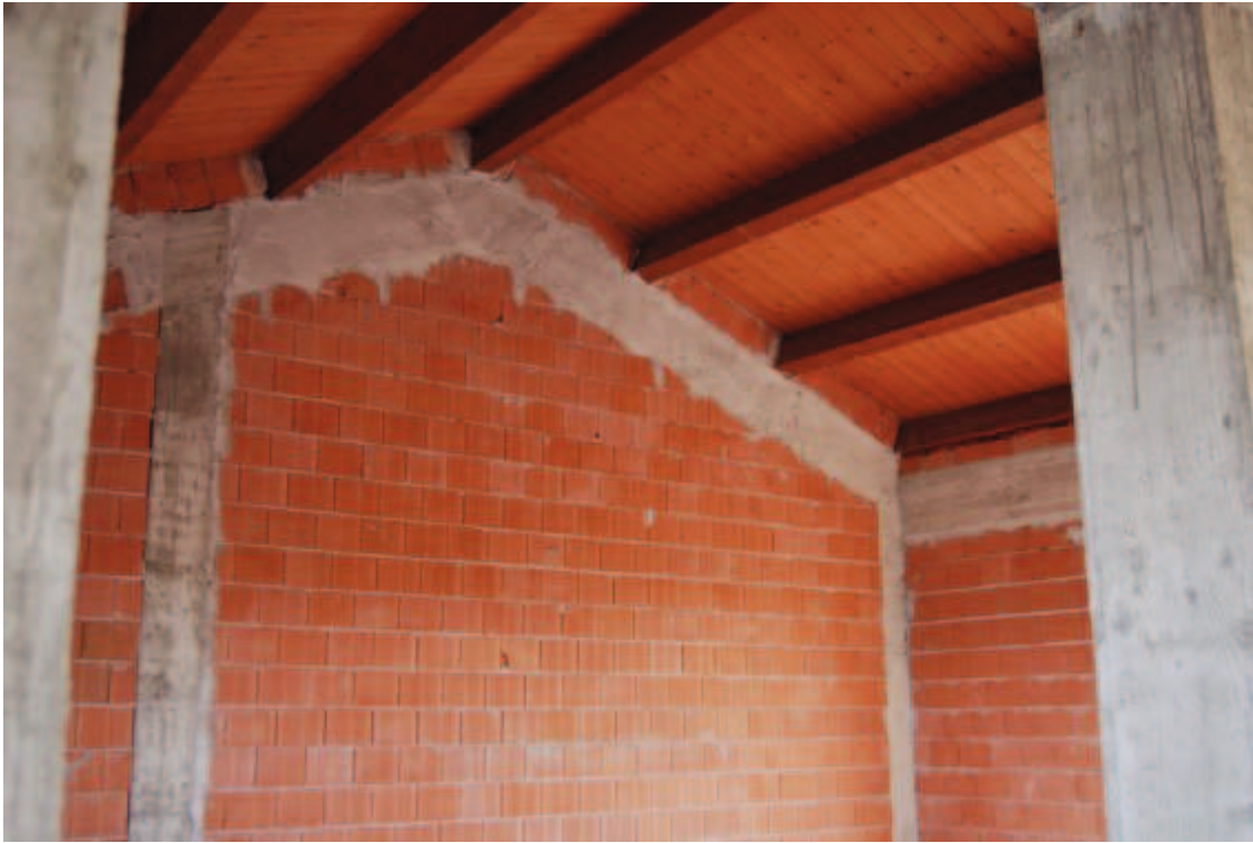
Fotografia C.30 - Condominio Azalea - particolare copertura interno
