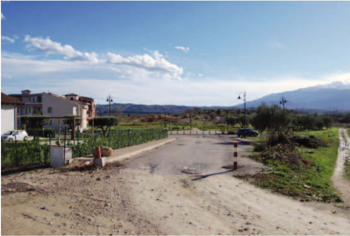
Fotografia C.2 - Urbanizzazione - Ingresso da via Colle di Popoli
