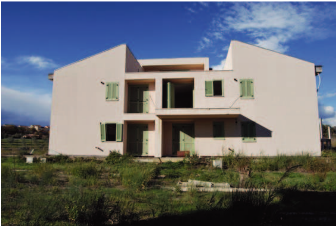
Fotografia C.9 - Condominio Ginestra - Prospetto SUD
