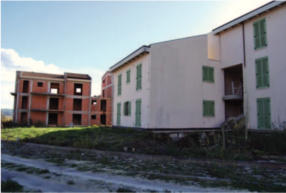
Fotografia C.8 - Condominio Ginestra - Prospetto lato strada di lottizzazione
