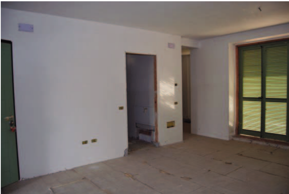
Fotografia C.17 - Condominio Ginestra - Interno appartamenti 2
