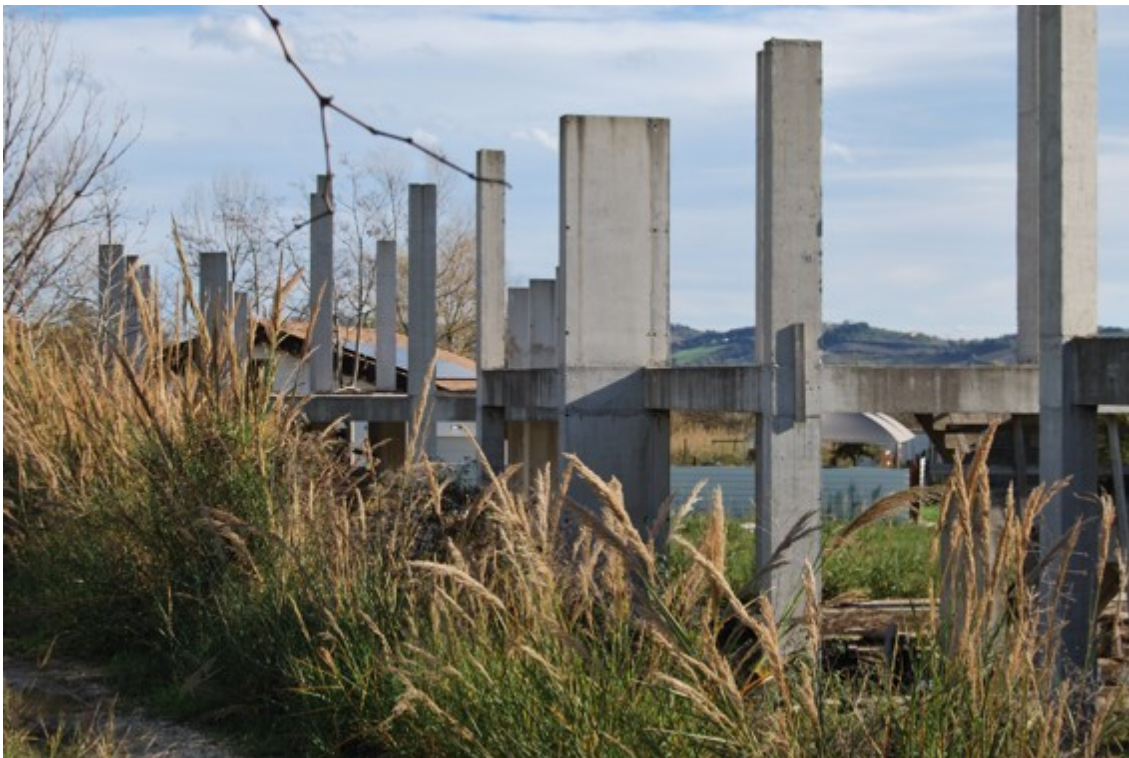
Fotografia C.2 - Prospetto lato strada comunale esterna alla lottizzazione
