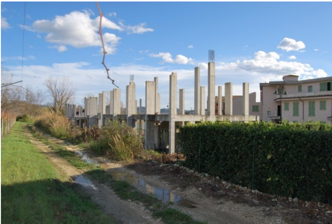
Fotografia C.2 - Prospetto lato strada comunale esterna alla lottizzazione
